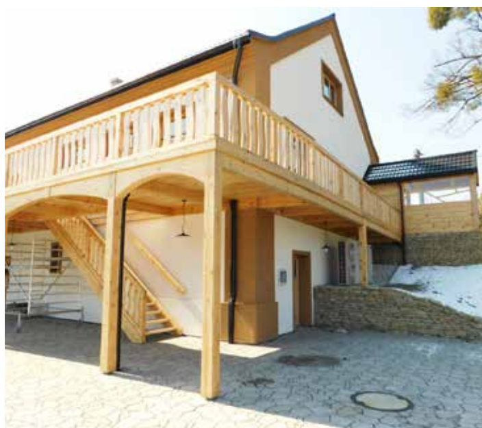
Architektonicky zajímavé jsou i nové prvky z druhé strany budovy
