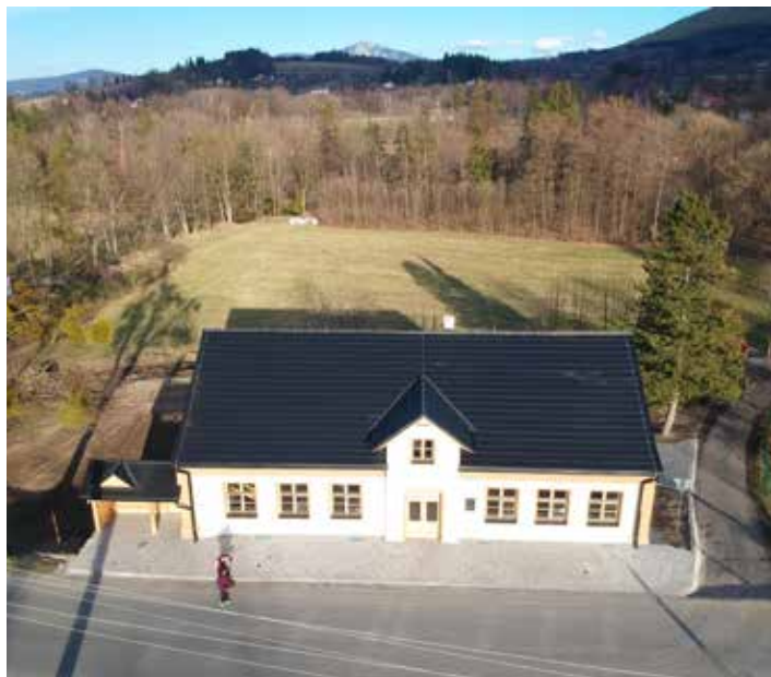
Pohled na opravenou budovu z dronu s impozantním pozadím
