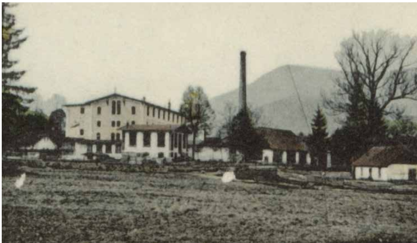
Pohled na mechanickou tkalcovnu bratří Žaarů ze strany od řeky Čeladenky
