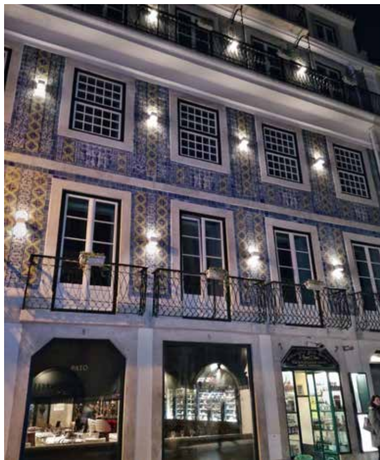
Azulejos neboli modračky – obklady budov glazovanými dlaždicemi
