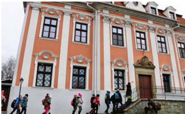
Nádhera! Dříve fara, pak škola. Dnes patří zrekonstruovaná budova záchranné stanici.
