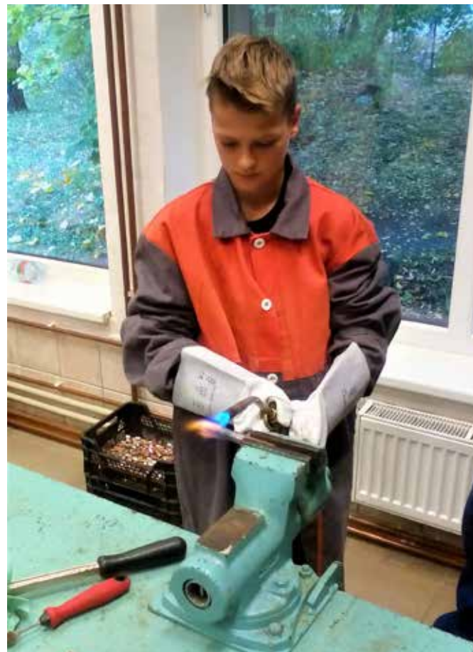
Obor instalatér: Vojta zkouší jednu z mnoha dovedností instalatéra – pájí měděnou trubku
