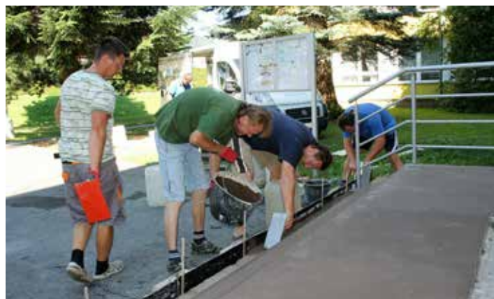
Drobná, leč z bezpečnostního hlediska významná novinka letošního školního roku. Nájezdová rampa u hlavního vchodu dostává nový povrch
