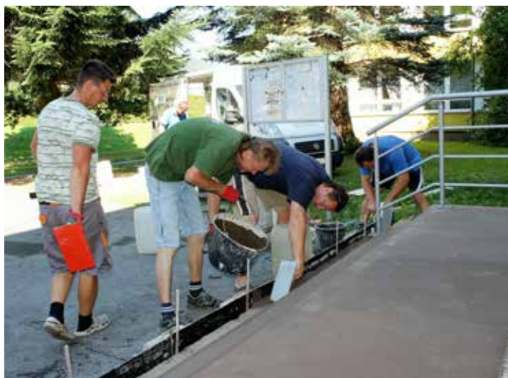
Schody a nájezdová rampa u hlavního vchodu dostává nový kabát.
