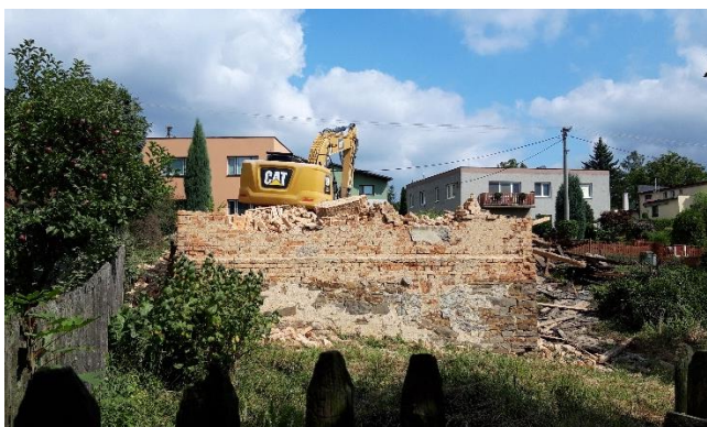
Demolice – pohled z ulice Na Kaluži
