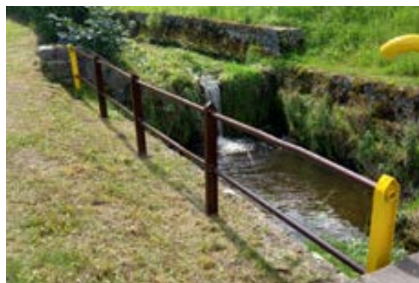
... a staré obnoví novým nátěrem.
