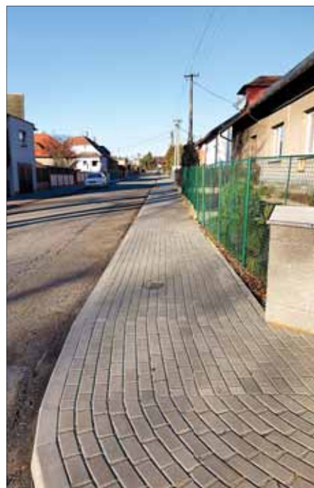
...a po rekonstrukci.
