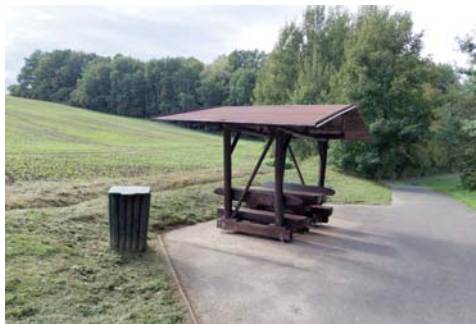
Na cyklostezce za čistírnou odpadních vod byl opraven altán.
