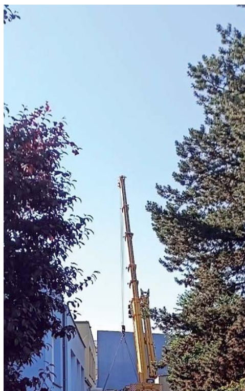
Demontáž tepelných čerpadel ze střechy kotelny.
