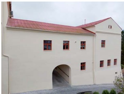
Rovněž byla dokončena II. etapa oprav fasády na objektu č. p. 22 (budova radnice).
