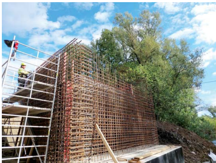
Záběry z průběhu stavebních prací na rekonstrukci mostu přes Ondřejnici na Trnavské cestě. Investorem této akce je Správa a údržba silnic MSK a. s.
