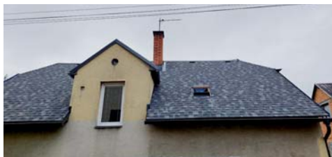
Na obecním domě č.p. 270 byla položena nová střešní krytina.
