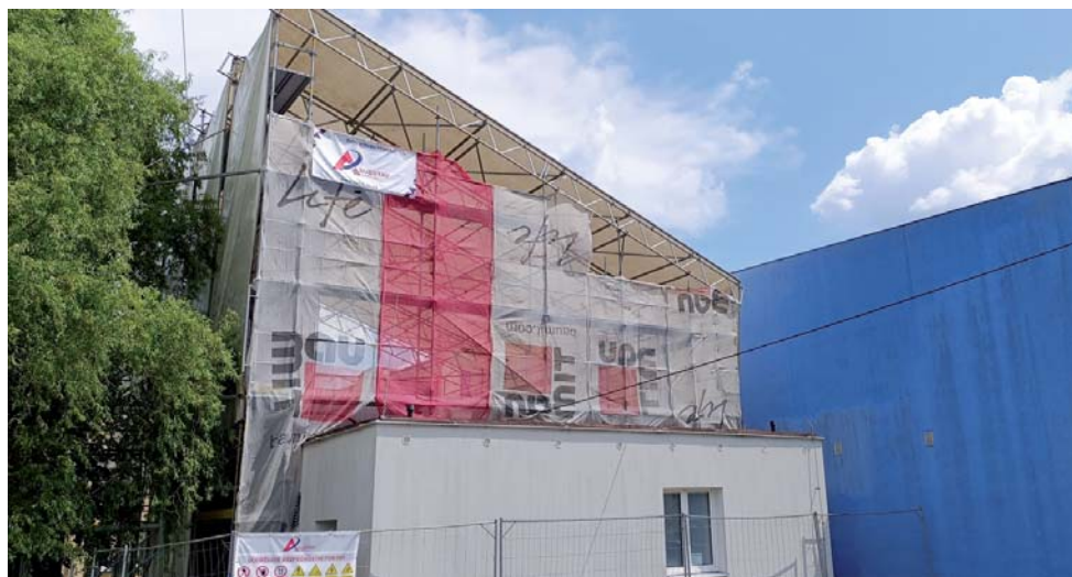
Oprava střechy kotelny.
