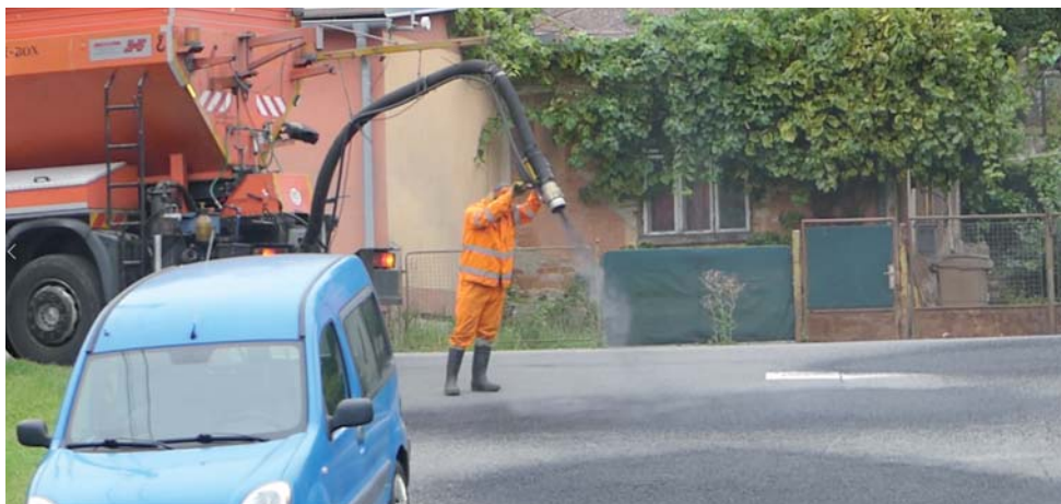
Na místních komunikacích byly opraveny drobné výtlučky a praskliny ve vozovce.
