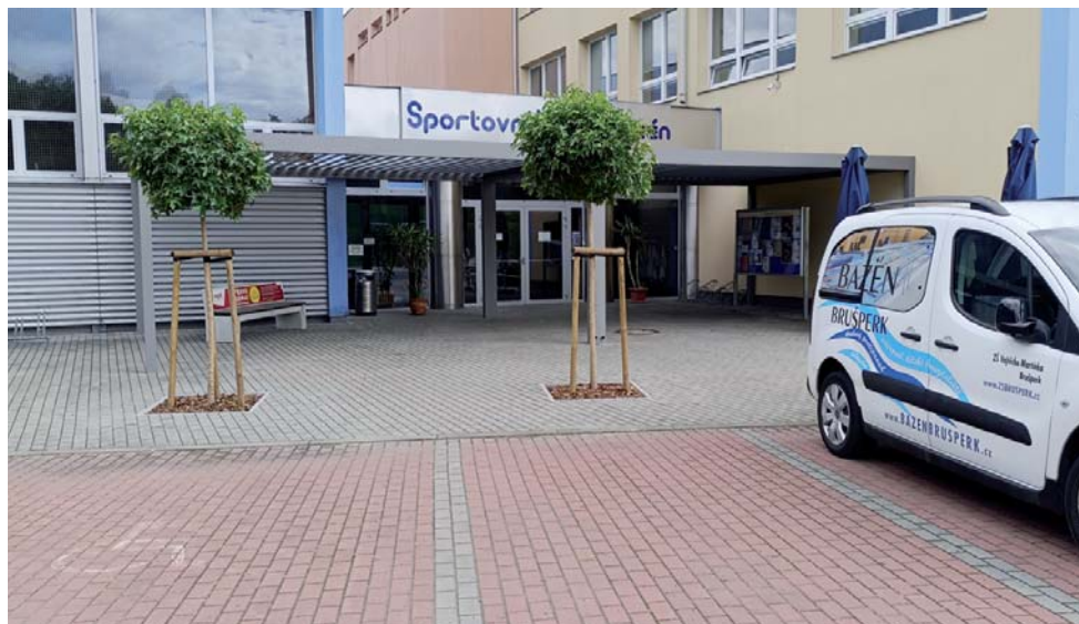
Modernizace vstupu před sportovní halou a bazénem.
