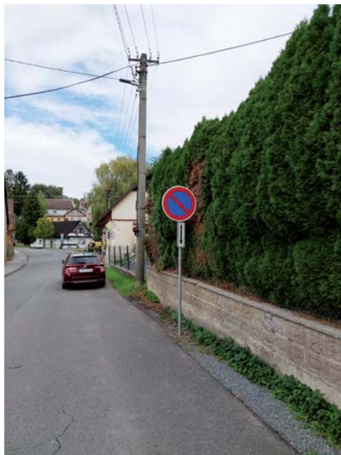
Na ul. Dr. Martíňka byly umístěny nové svislé dopravní značky „zákaz stání“ v úseku tzv. „Kulového kopečku“.
