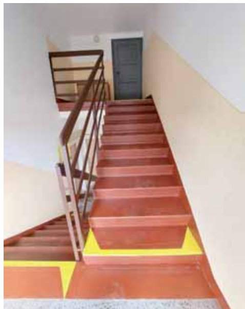
Nová výmalba a nátěry v obecním domě č. p. 581.
