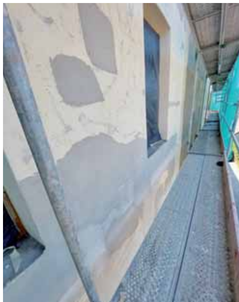
Pokračují práce na opravě fasády budovy radnice.
