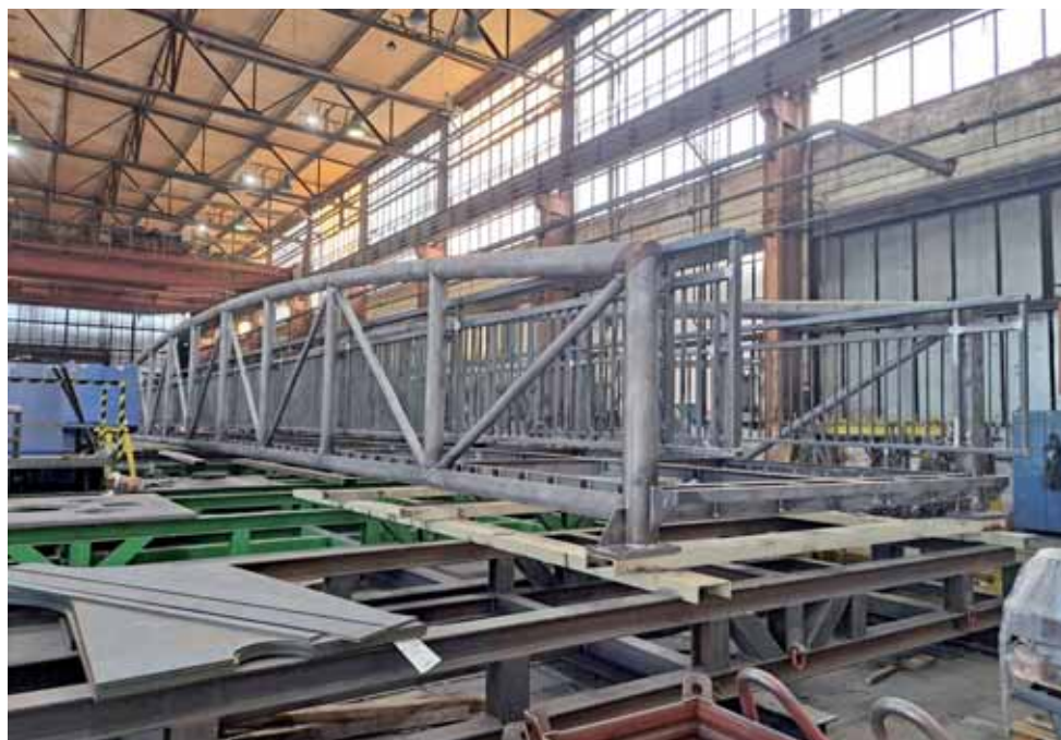
Nová ocelová lávka přes řeku Ondřejnici na budované cyklostezce Brušperk–Fryčovice.
