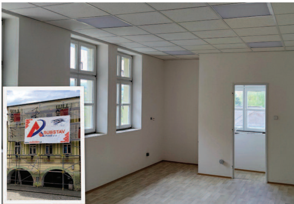
Probíhá rekonstrukce nebytových prostor v přízemí Národního domu a oprava římsy.
