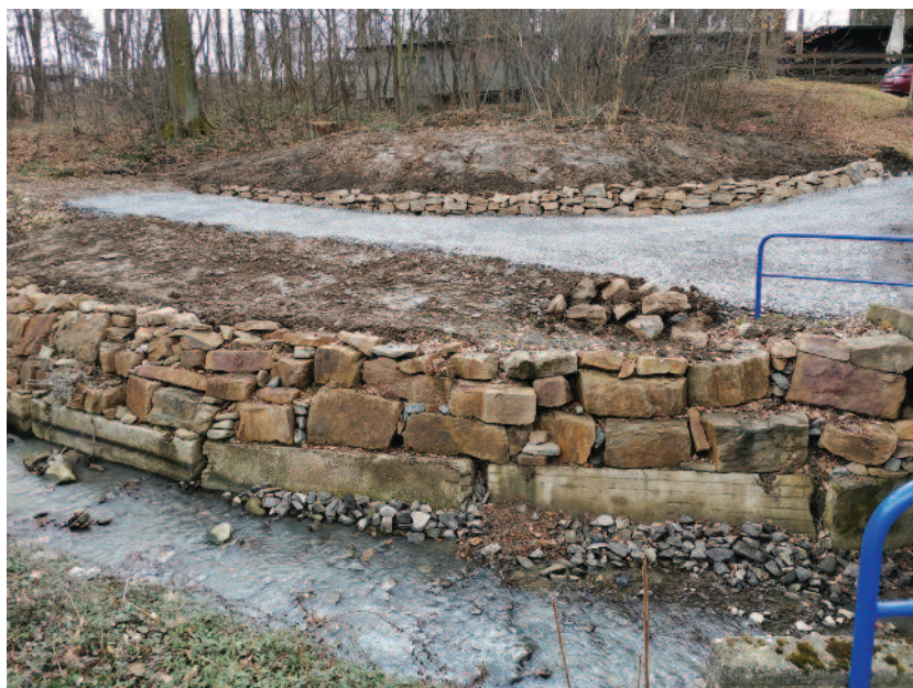
Sanace svahu u areálu Pastevník.
