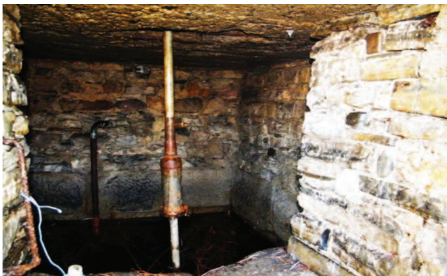
Pohled dovnitř studny.
