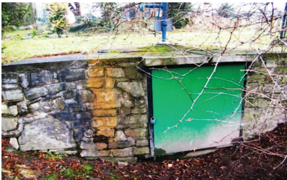
Pohled na studnu zvenčí.
