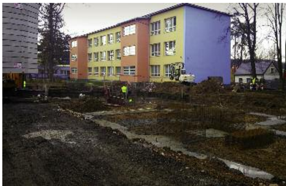
Stavba nového pavilonu u Základní školy V. Martínka
