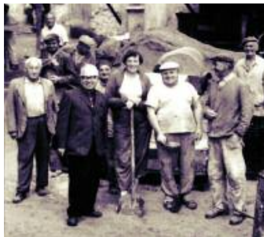
Na fotografii oprava kostela v roce 1968
