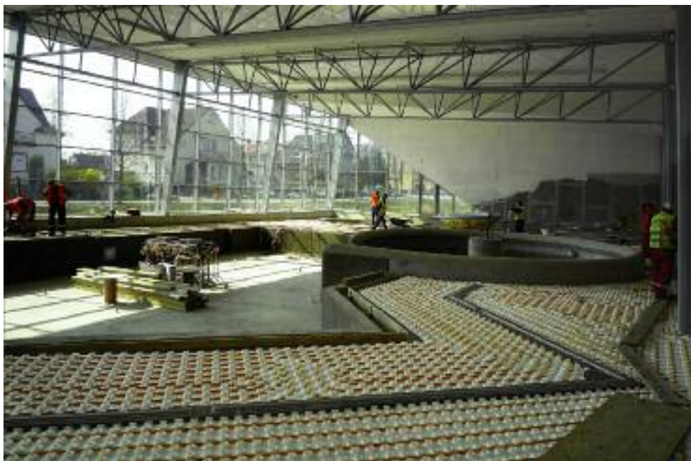
Stavební práce v krytém bazénu pokračují
