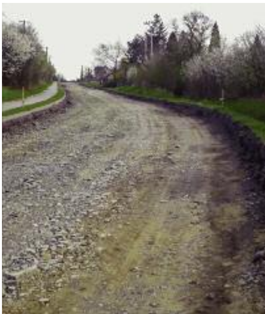
Oprava silnice ke Krmelínu
