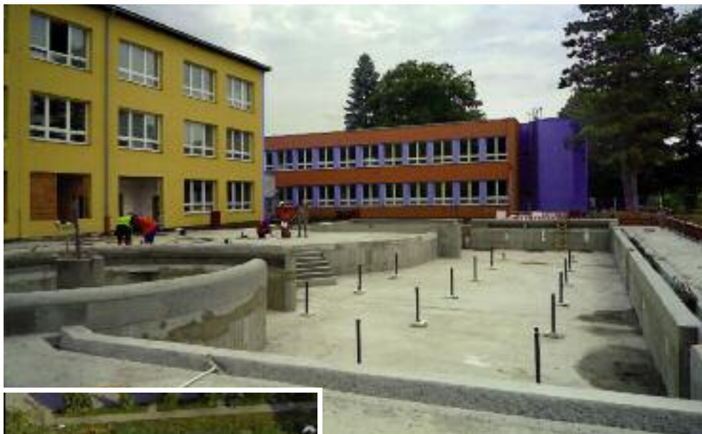
Výstavba bazénu. Letecké snímky Romana Seltenreicha
