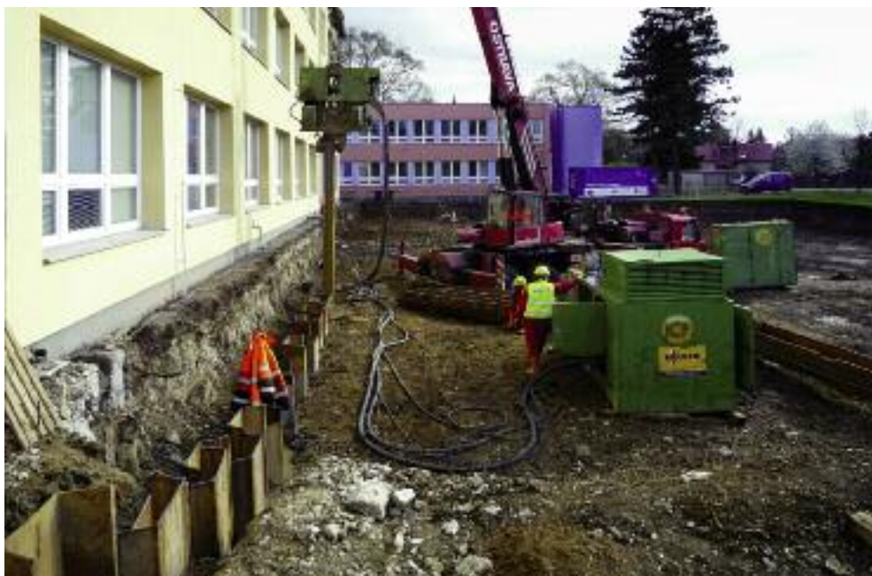
Výstavba bazénu, začátek výkopových prací
