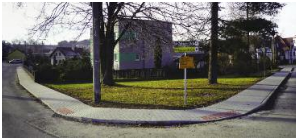
↑ Rekonstrukce chodníku na ul. Jožky Matěje
