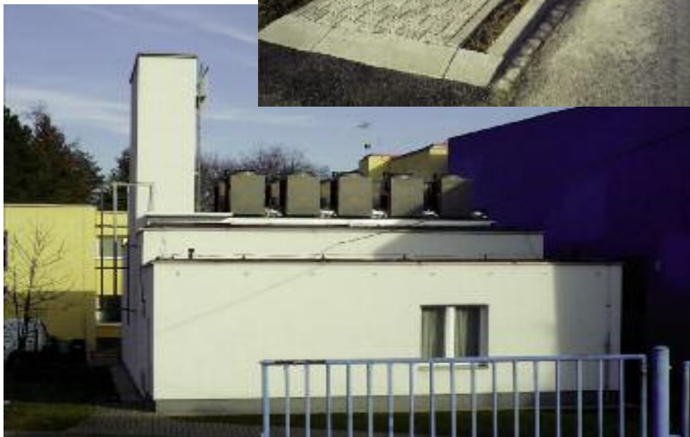
↓ Rekonstrukce vytápění ZŠ — plynová tepelná čerpadla na střeše kotelny
