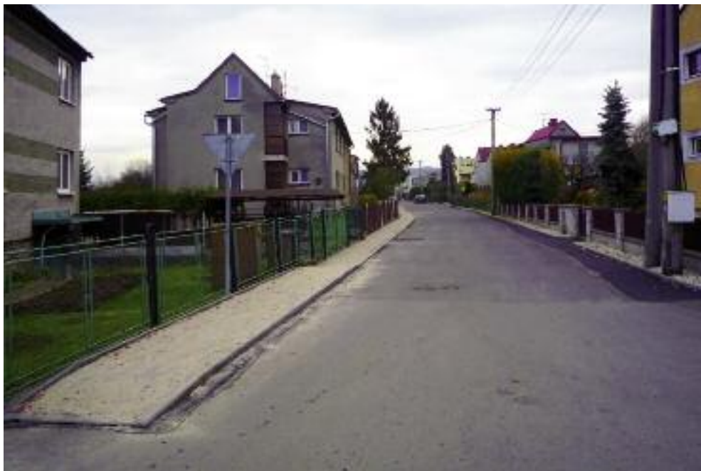
Výstavba chodníku na ulici U Tří lip
