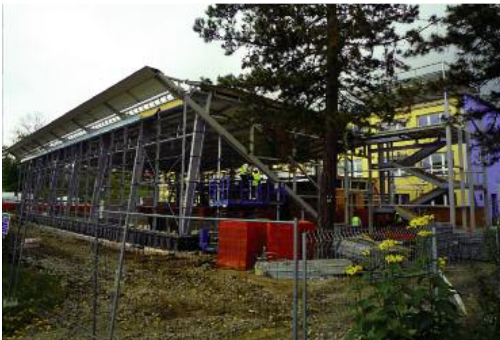
Práce ve městě — výstavba bazénu
