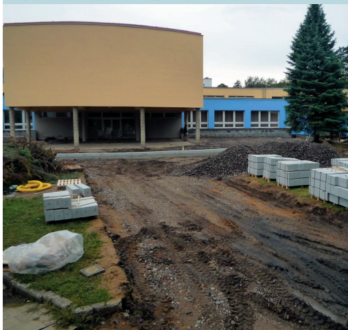
Výstavba zpevněných ploch před ZŠ
