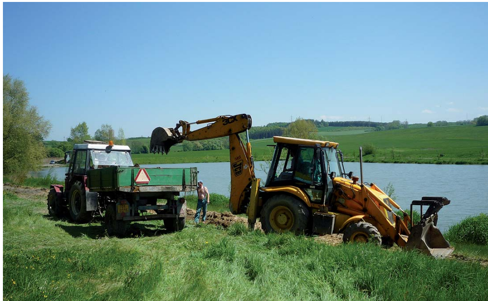
Stavba chodníku u rekreační přehrady.
