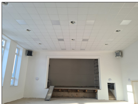
Strop v sále multifunkčního domu je již hotov.
