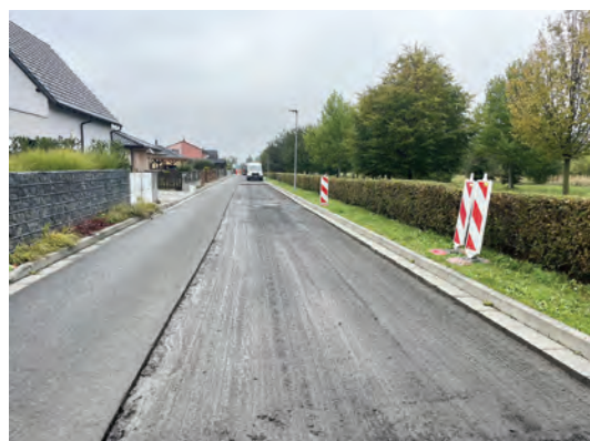
Oprava ul. Severní
