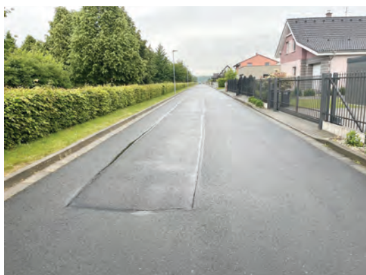
Oprava ul. Severní
