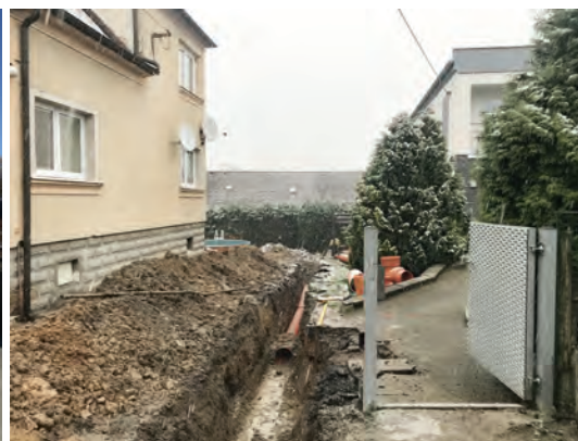
Kanalizace Hlučínská a Svobody
