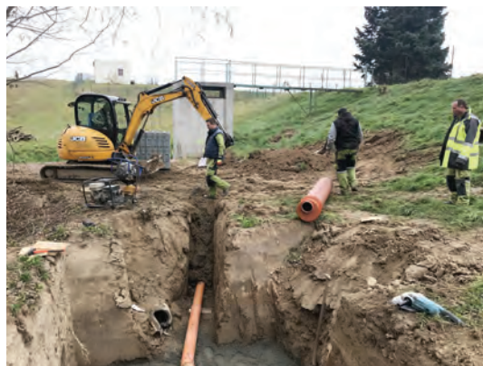
Kanalizace za koupalištěm
