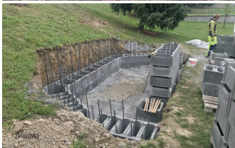
Kanalizace ul. Svobody a Hlučinská
