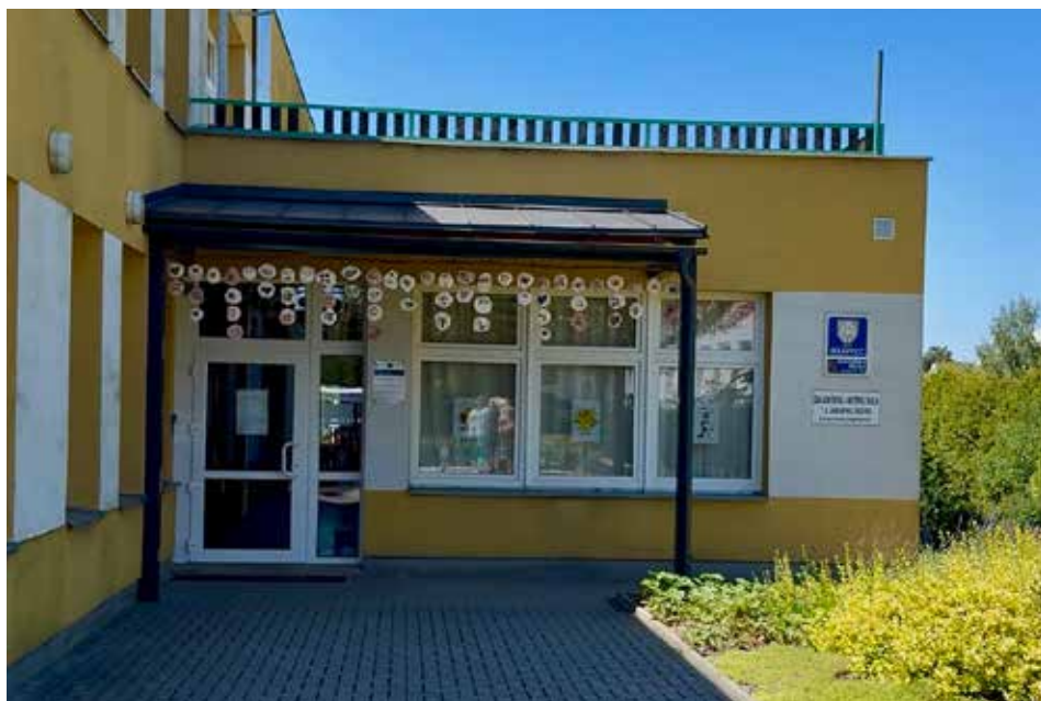
O prázdninách probíhala rekonstrukce sociálního zařízení v MŠ Wolkerova.
