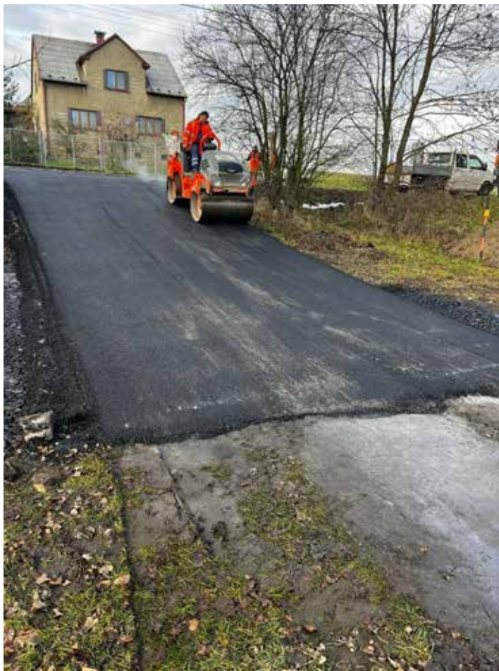
Oprava sjezdu v Lubojatech patří k projektům, jimiž krok za krokem zvelebujeme místní části.
