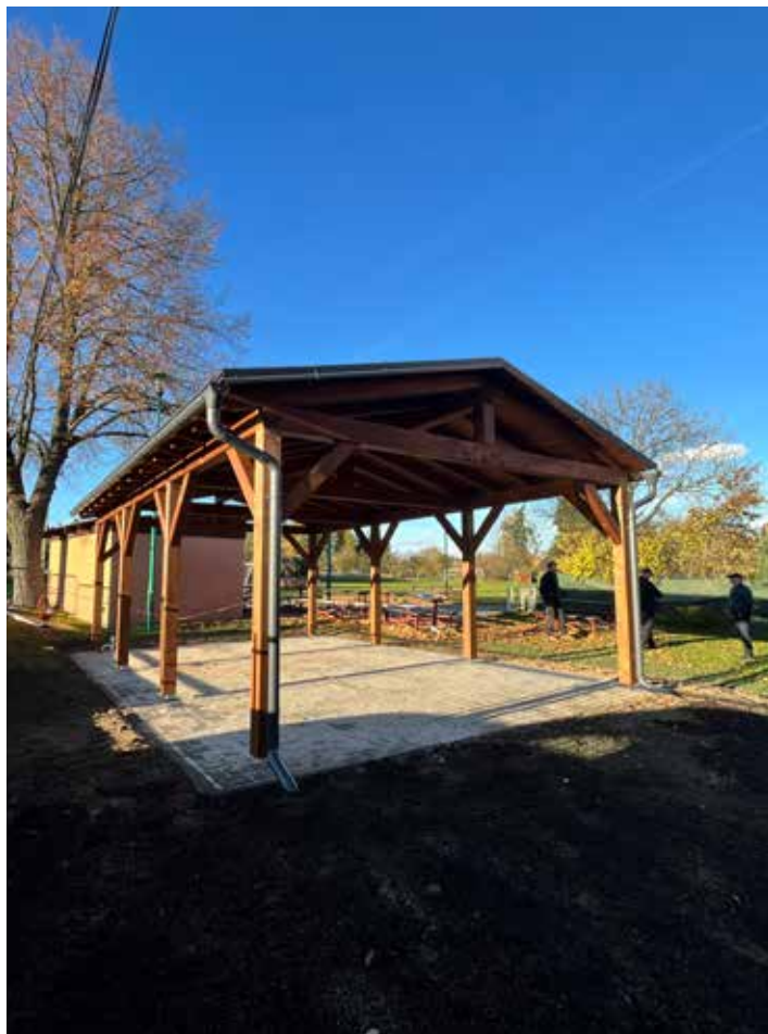
Přístřešek ve Výškovicích.
