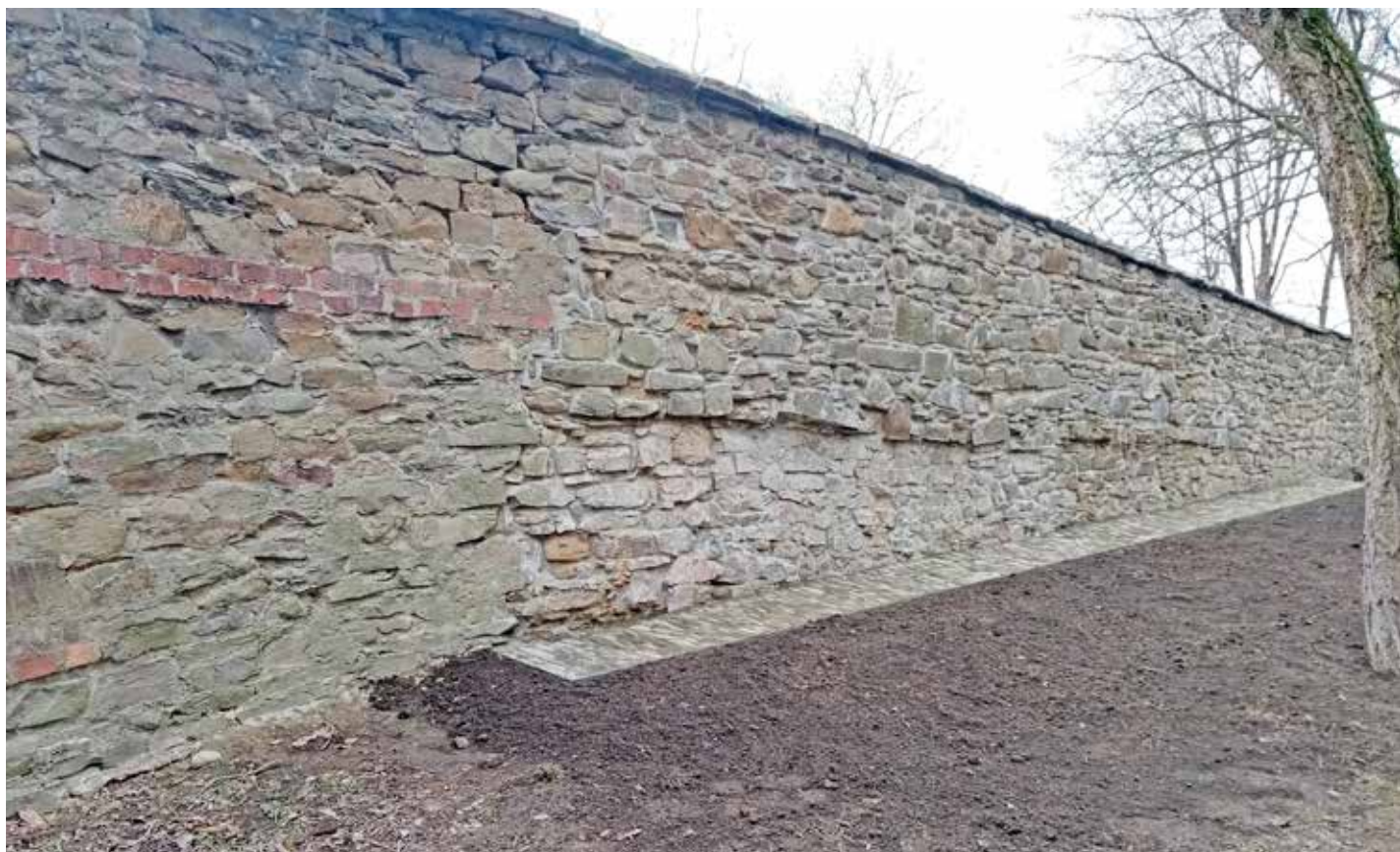
Snímek zrekonstruované ohradní zdi kolem zámku.
