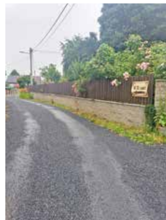
Zpevnění cest v Bravinném penetračním makademem.
