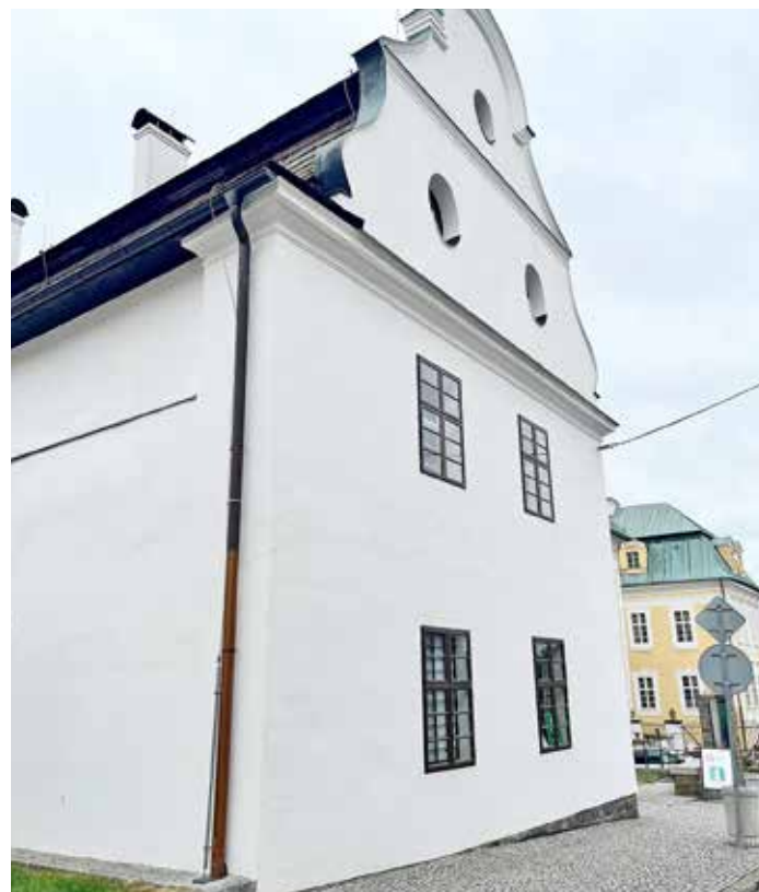
Loni na podzim byla obnovena fasáda muzea.
