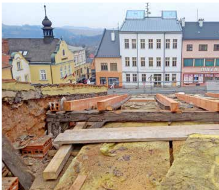
Stav po odhalení střechy domu č. 9 na Slezském náměstí.
