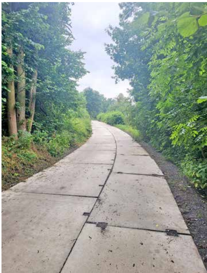
Příjezdová komunikace ve Staré Vsi.
