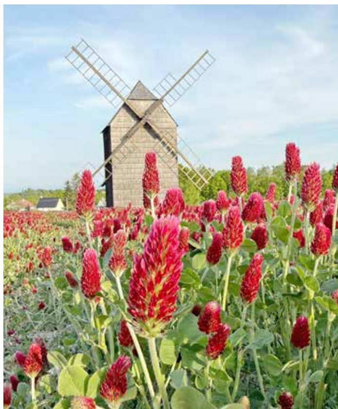
Větrný mlýn v Nových Dvorech. Letos na jaře tu bylo vybudováno nové schodiště a šindelová střecha nad ním.
