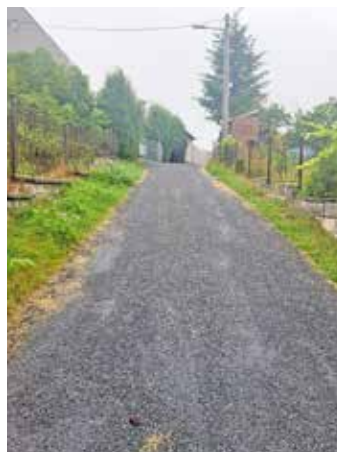
Zpevnění cest v Bravinném penetračním makademem.
