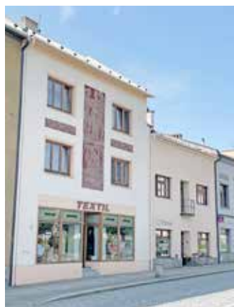
Rekonstrukce fasád byla dokončena v termínu.
