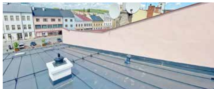
Rekonstrukce první střechy domu (č. p. 9) na Slezském náměstí je dokončena.
