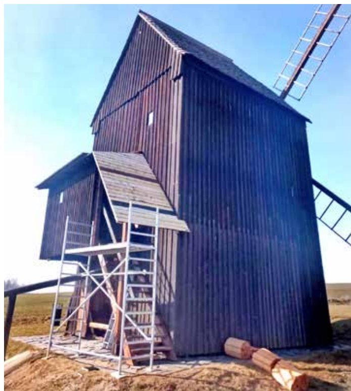
Budování nového schodiště a střišky mlýna
