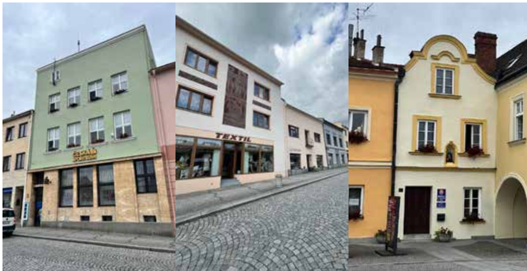
Kromě fasád několika objektů, včetně radnice, procházejí rekonstrukcemi i střechy některých domů na Slezském náměstí.
