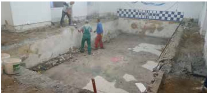
Modrá laguna během rekonstrukce...
