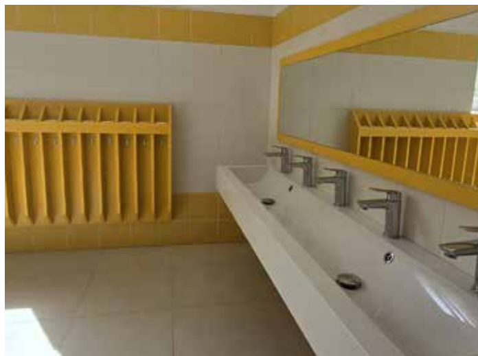
... a po rekonstrukci.
