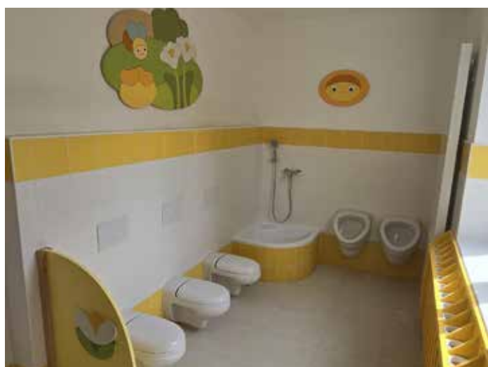
... a po rekonstrukci.
