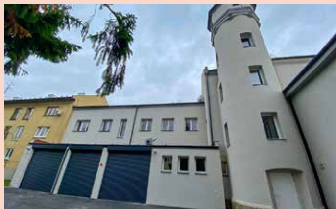
...a po rekonstrukci
