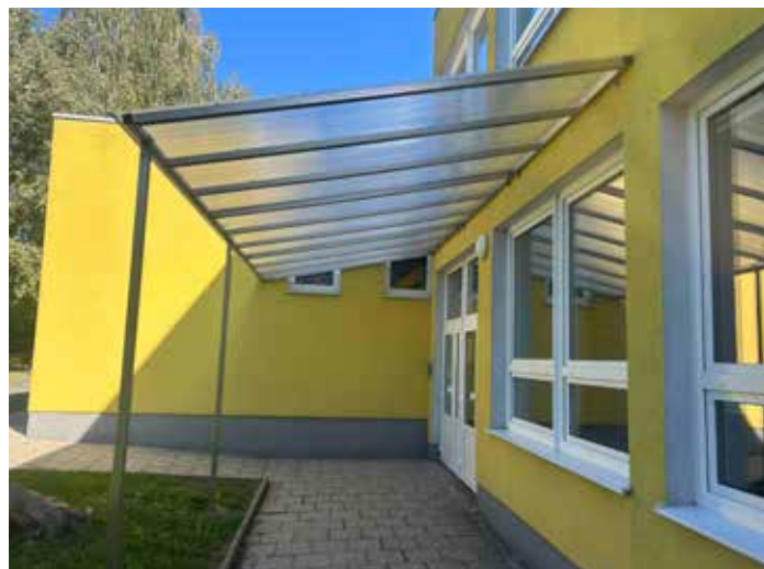
Budova B má nové přístřešky nad vchody.
