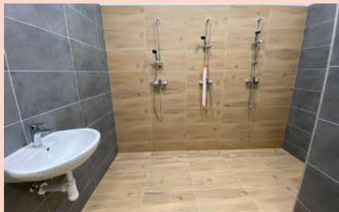
...a po rekonstrukci
