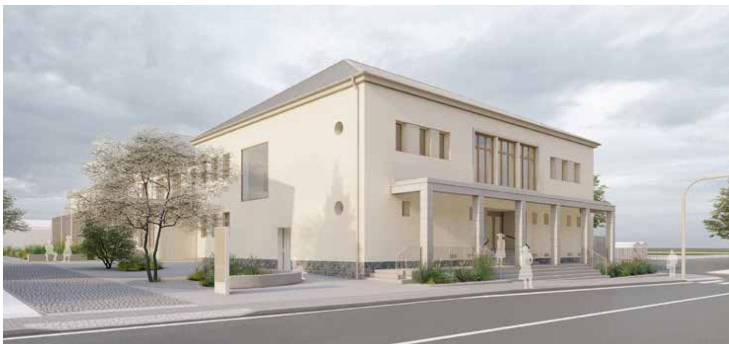
Velkým tématem příštích let bude rekonstrukce kulturního domu.
