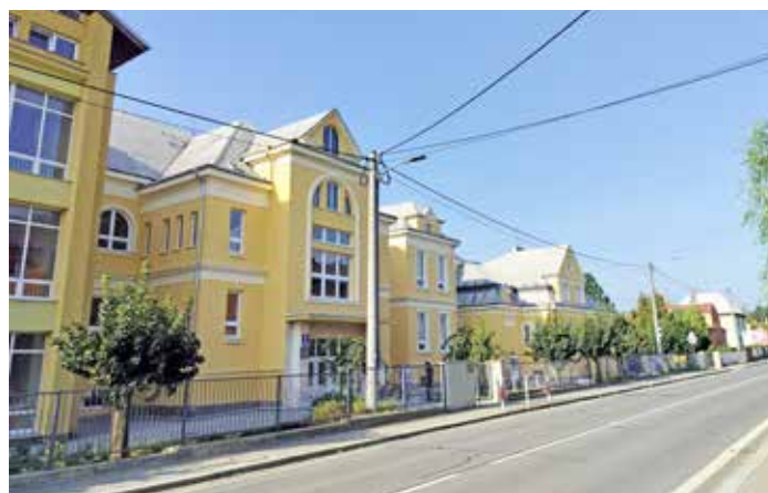
Díky investici v hodnotě 5,8 milionu korun dnes fasáda staré budovy ZŠ TGM doslova září.
