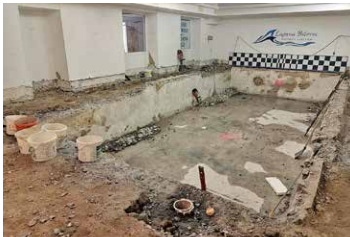
Laguna v průběhu rekonstrukce...
