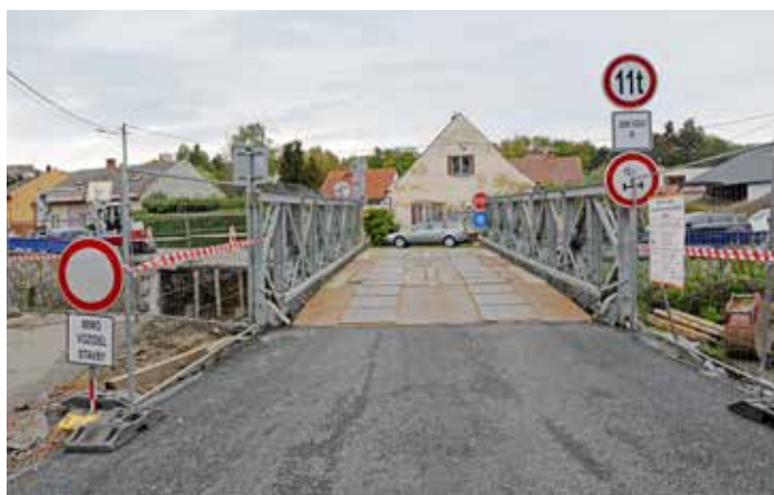
K zásadním investičním akcím patřila rekonstrukce mostu na Mlýnské ulici. Hodnota akce je více než 10 milionů korun.
