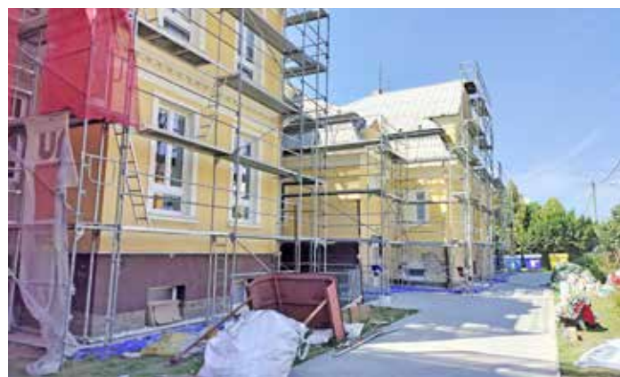
Oprava fasády budovy ZŠ TGM.
