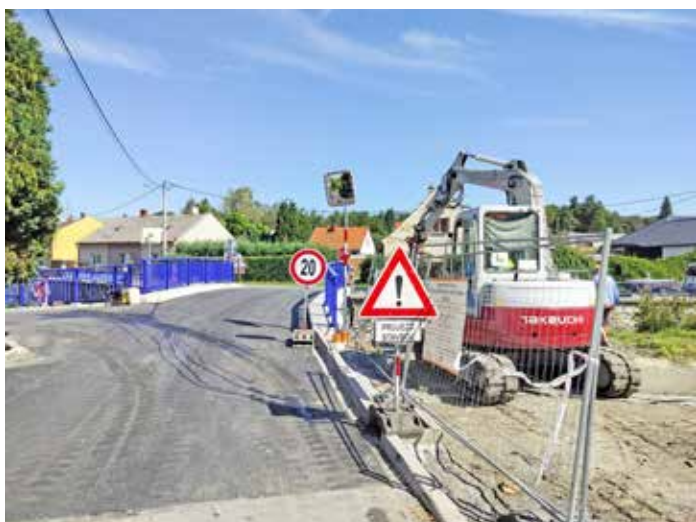
V září bude finišovat stavba mostu v Mlýnské ulici.
