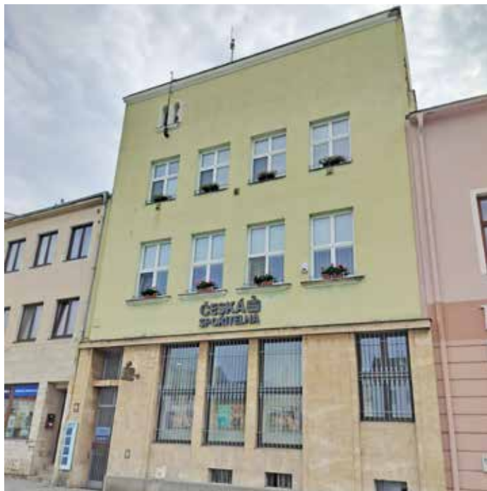
Půvab Slezského náměstí podtrhnou nové fasády a zrekonstruované střechy...
