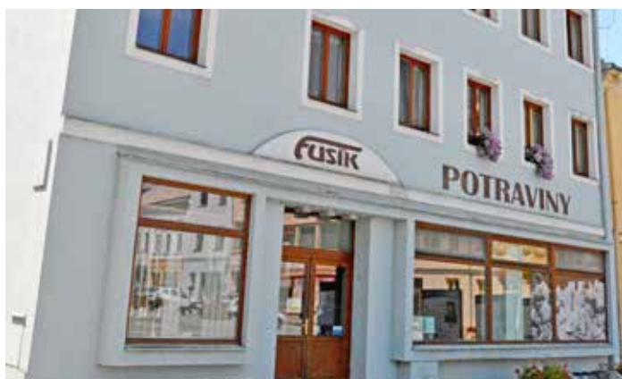
Na Slezském náměstí o prázdninách finišovala rekonstrukce prodejny potravin.
