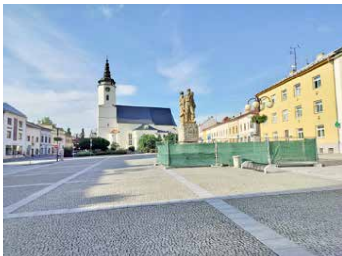
Rekonstrukce kašny na Slezském náměstí.
