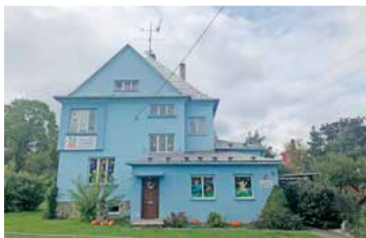
Budova v ulici Tovární č. 188
