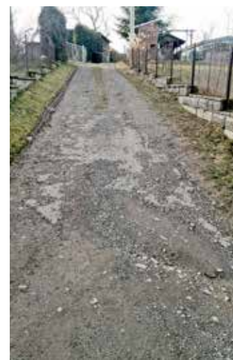
Komunikace u domu č. p. 31
