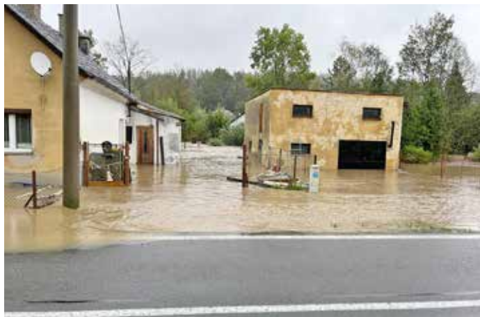
„Nejhorší situace byla na třech místech. U panelového domu
