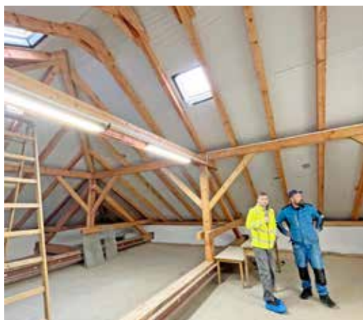
Nový krov střechy ZŠ Lubojaty
