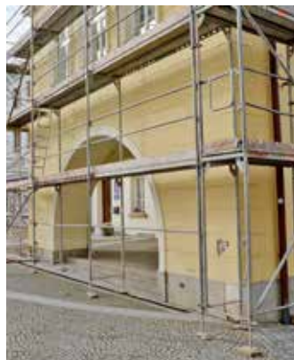
Oprava fasády radnice
