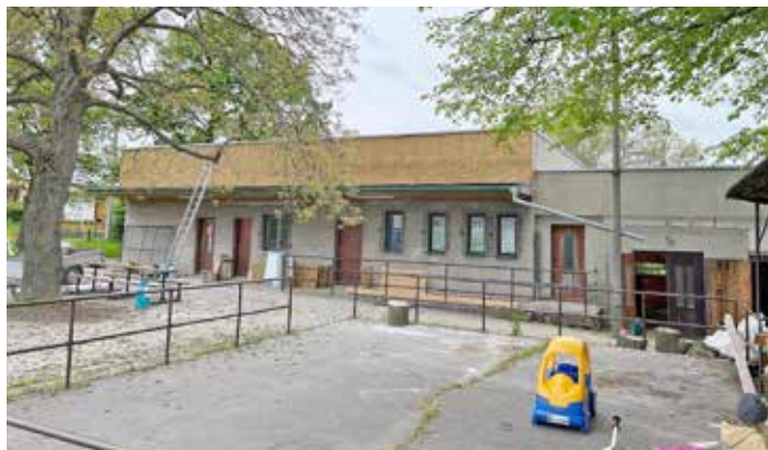
I. etapa rekonstrukce šaten u fotbalového hřiště v Lubojatech
