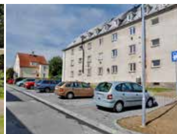
8. Výstavba odstavných ploch na ulici Puškinova
