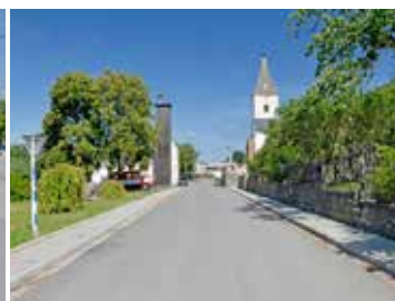
3. Opravená komunikace v Bravinném
