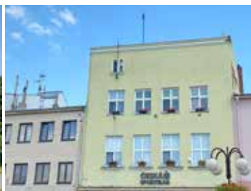
2. Rekonstrukce nových bytů na náměstí
