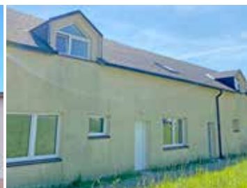
3. Oprava bytů v zakoupeném objektu na Radotíně
