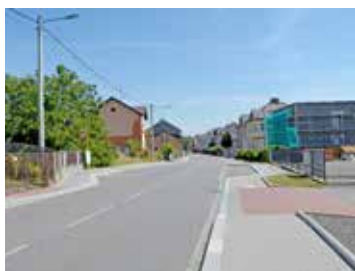
1. Rekonstrukce ulice Čs. armády
