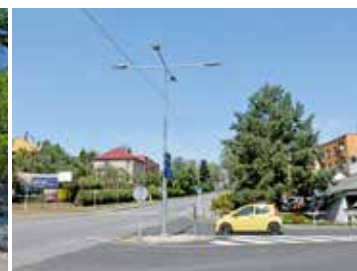
4. Výměna veřejného osvětlení
