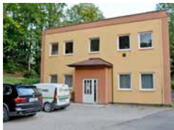
5. Oprava kanalizace v kuželně
