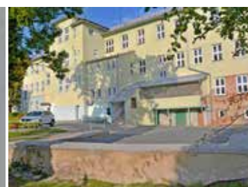
4. Demolice havarijní budovy za úřadem
