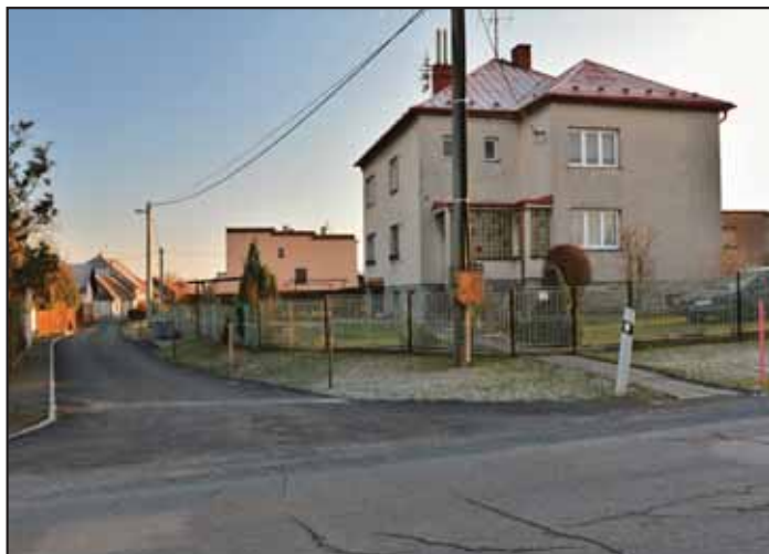
Výškovice – oprava komunikace k domu pana Hrušky Celkové náklady: 342 tis. Kč
