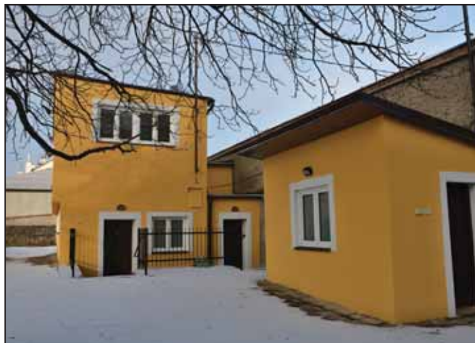
Letní kino Bílovec – oprava budov v areálu letního kina Celkové náklady: 746 tis. Kč
