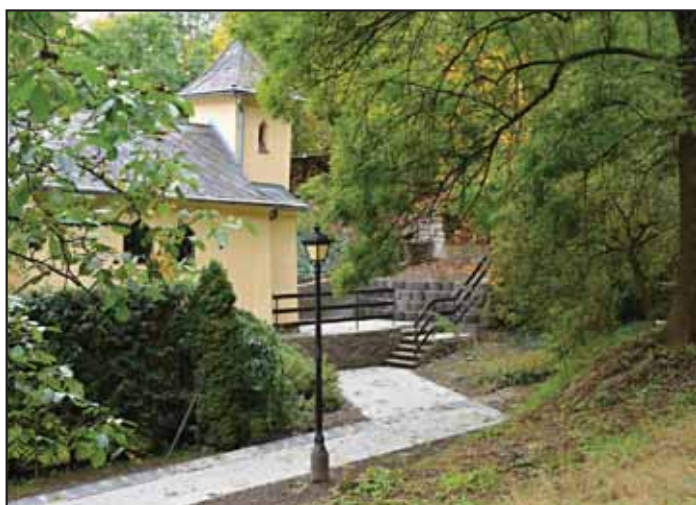
Kaple Panny Marie Pomocné v Bílovci – oprava vstupních ploch Celkové náklady: 334 tis. Kč
