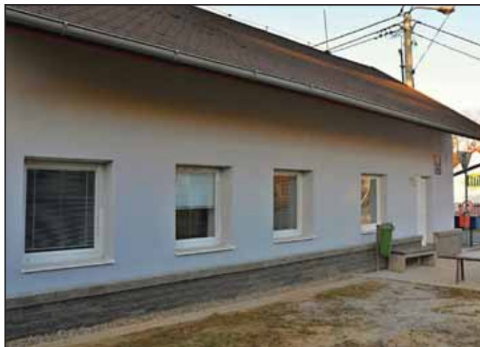
Lhotka – oprava budovy osadního výboru Celkové náklady: 222 tis. Kč
