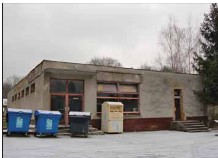
Demolice objektu na Střelnici Celkové náklady: 394 tis. Kč
