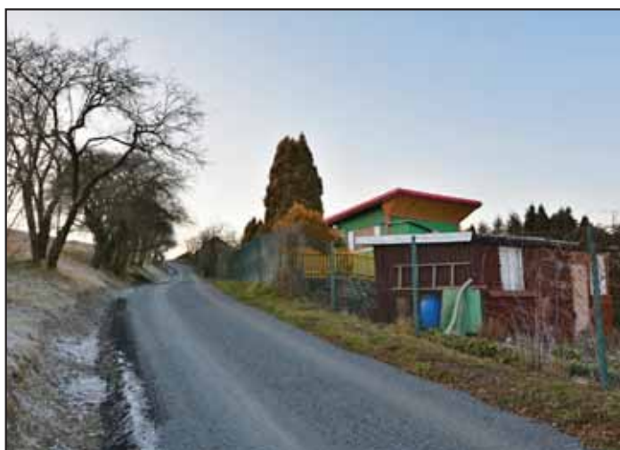
Oprava příjezdové komunikace k zahrádkám z ul. Opavská v Bílovci Celkové náklady: 355 tis. Kč
