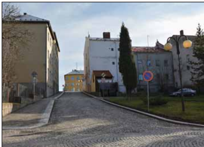
Oprava a předláždění komunikace mezi Slezským náměstím a Tkalcovskou ulicí v Bílovci Celkové náklady: 923 tis. Kč
