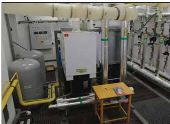
ZŠ a MŠ T. G. Masaryka v Bílovci – rekonstrukce kotelny, ústředního topení Celkové náklady: 2 054 tis. Kč
