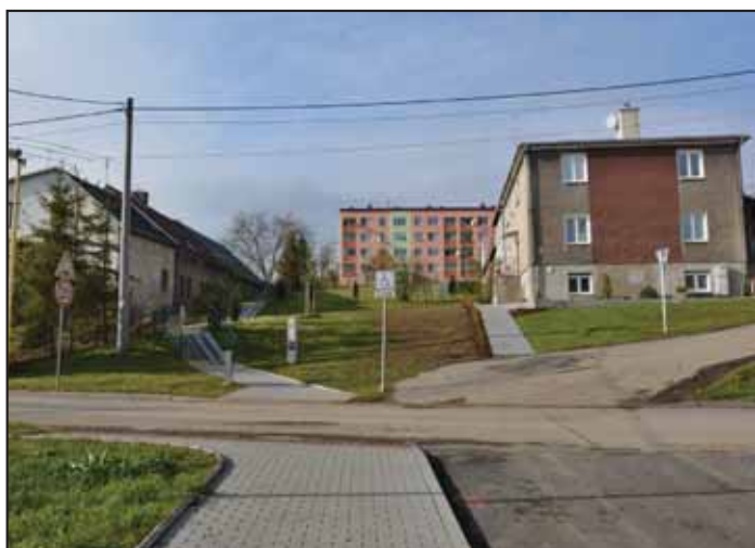
Radotínská ul. – vybudování a oprava chodníku před domem č. p. 572 Celkové náklady: 120 tis. Kč
