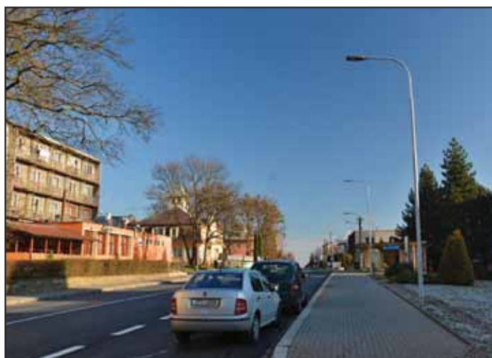
Rekonstrukce veřejného osvětlení na ul. Ostravská v Bílovci Celkové náklady: 725 tis. Kč
