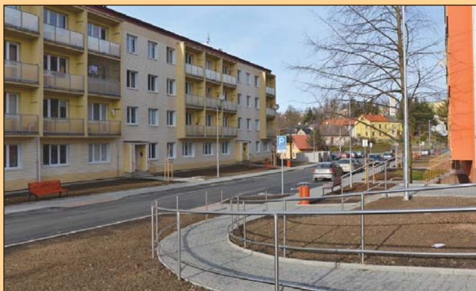
Ulice na Radotíně působí po rekonstrukci větším a vzdušnějším dojmem
