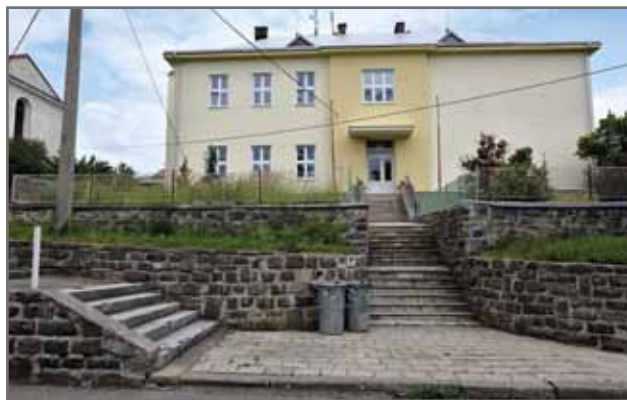
MŠ Bravinné – zateplení, tepelné čerpadlo, výměna oken
