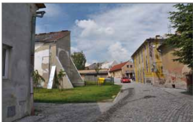
Rekonstrukce ulic Pivovarské (vlevo prostor po demolici objektu), Zámecké a Valové
