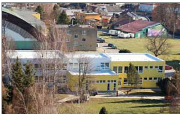
Zateplení budovy ZŠ Komenského: budova B
