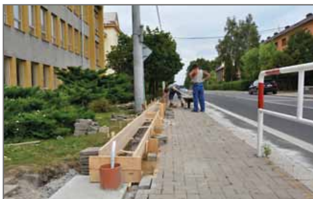
ZŠ TGM: nový plot, výměna oken, dveří a zateplení fasády
