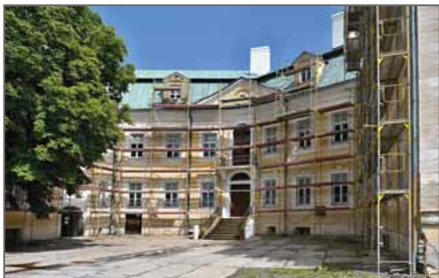
Zámek – schodiště, dveře, okna, kaple, fasáda
