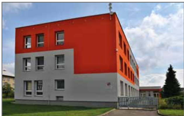
Zateplení budovy ZŠ Wolkerova
