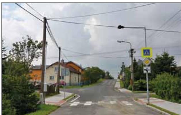
Lubojaty – vybudování nasvětleného přechodu, rekonstrukce chodníků
