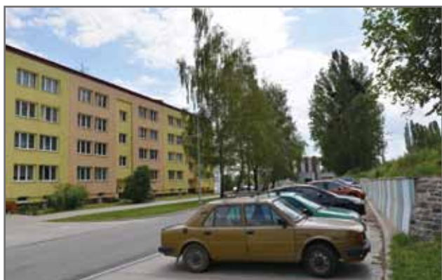
Parkoviště na Radotíně II
