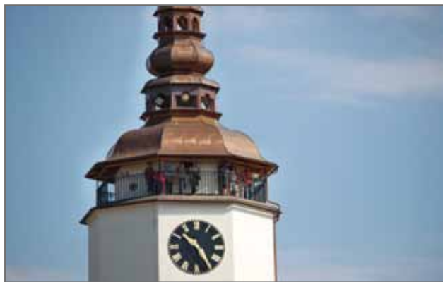
Rekonstrukce věže kostela sv. Mikuláše v Bílovci
