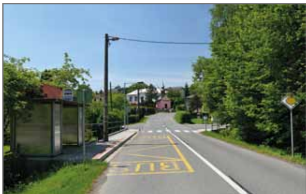
Lhotka – vybudování nasvětleného přechodu a chodníku
