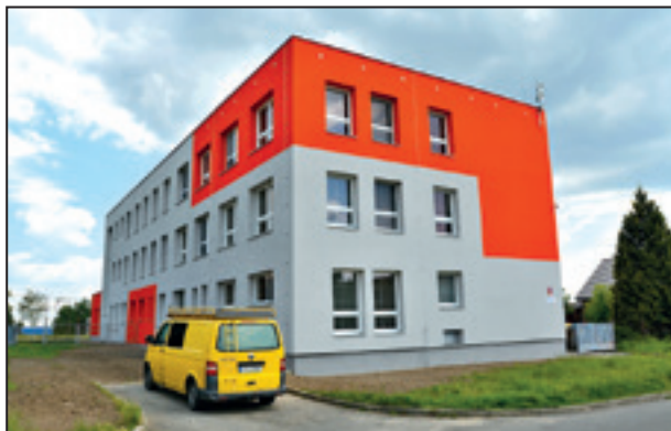
Zateplení ZŠ na Wolkerově ulici
