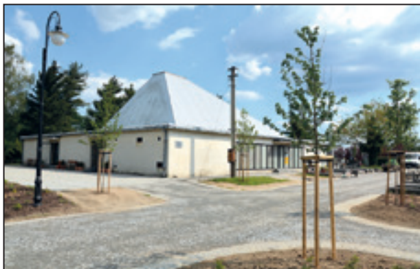
Rekonstrukce komunikací a zpevněných ploch na městském hřbitově v Bílovci
