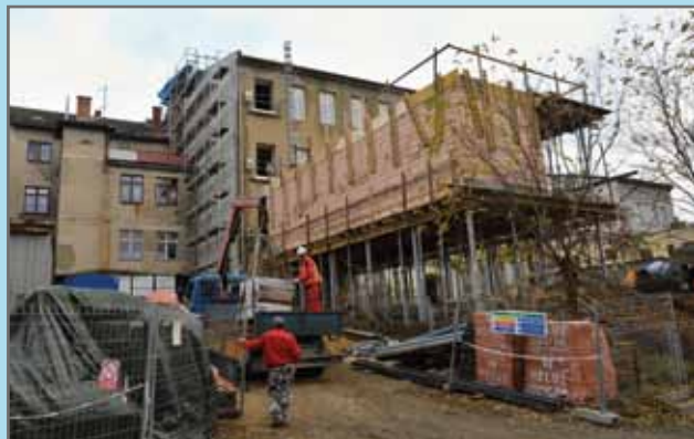
Stavba knihovny a centra pro seniory roste před očima
