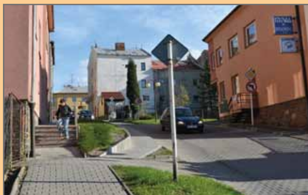
Nový bezbariérový chodník na spojení mezi ulicemi Tkalcovská a Příkopní
